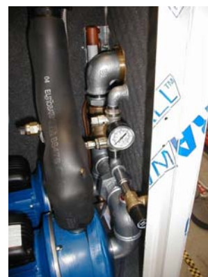
Узел заправки с манометром дренажный клапан предохранительный клапан на водяном контуре
