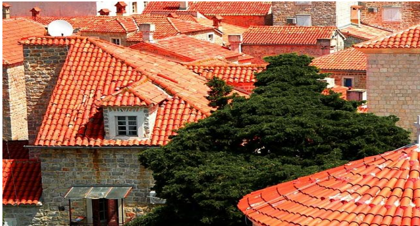
Рис. 17. Общий вид черепичной кровли
