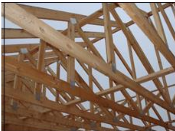
Рис. 9. Общий вид висячих стропил
