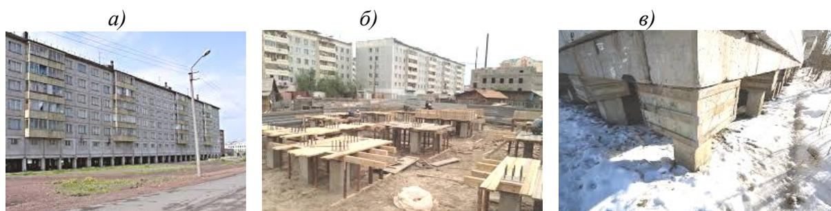
Рис. 15. Многоэтажные жилые здания из крупных панелей, возведенные на забивных железобетонных сваях, в условиях вечной мерзлоты с использованием принципа I (с сохранением многолетней мерзлоты): а – шестиэтажное здание с проветриваемым пространством; б – возведение свайных фундаментов жилого района; в – фрагмент конструкции свайного фундамента с высоким ростверком для проветривания пространства
