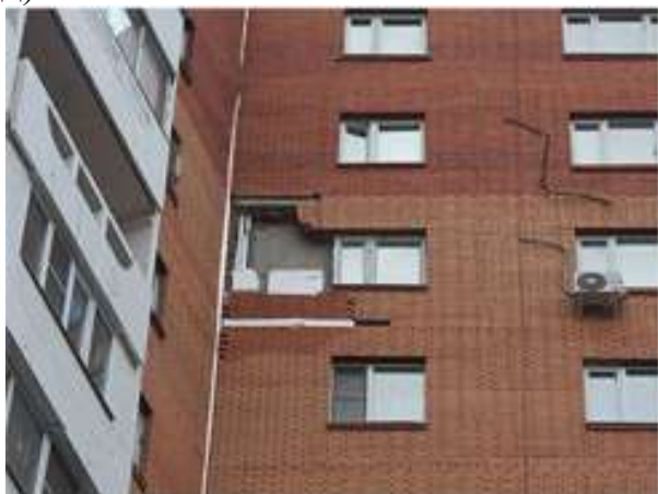
Рис. 3.15. Дефекты и разрушения в многослойных ограждающих конструкциях: а, б) разрушение глазурованного слоя керамического кирпича по линии перекрытий и перемычек; в) разрушение глазурованного слоя керамического кирпича в угловой зоне; г) разрушение кирпичной облицовки по утеплителю из пенопласта, д,е) разрушение кирпичной облицовки вместе с утеплителем
