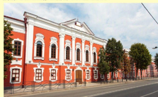
Большое здание Адмиралтйской конторы конец XVIII в. г. Казань, ул. К.Маркса, 17 и.о. доц. каф. градостроительства Ф.М. Забирова 2013 г.
