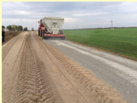
Распределение вяжущего - цемента цементораспределителем
