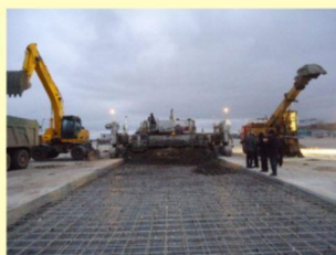
Экспериментальный участок перрона Аэропортового комплекса г. Казани с применением полимеркомпозитной арматуры
