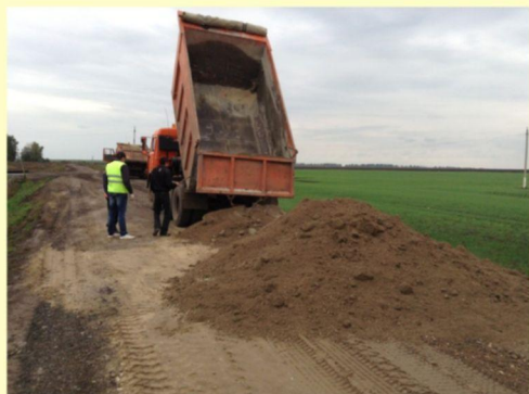
Подвоз грунта и минеральных материалов автосамосвалами
