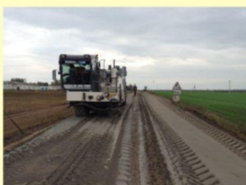
Устройство экспериментальных участков на автомобильной дороге «Подъезд к н.п. Кульбаево-Марса» в Нурлатском р-не РТ
