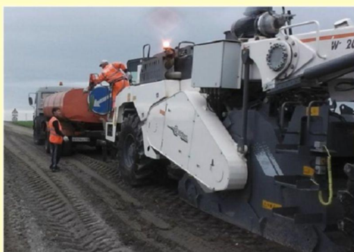
Введение модифицирующих добавок системой распределения ресайклера с одновременным смешением
