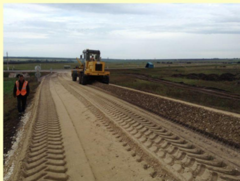
Распределение и планировка грунта и минеральных материалов автогрейдером
