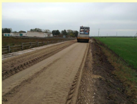
Уплотнение готовой смеси
