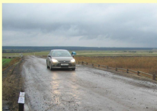
Движение транспорта по экспериментальным участкам дороги
