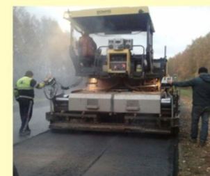
Устройство полимераасфальтобетонного покрытия на экспериментальном участке автомобильной дороги «Большой Кульбаш – Дубыйка»
