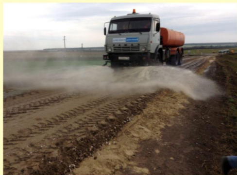
Розлив воды поливочной машиной
