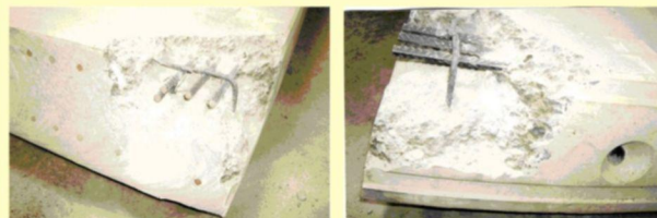
Коррозия арматуры не наблюдается
